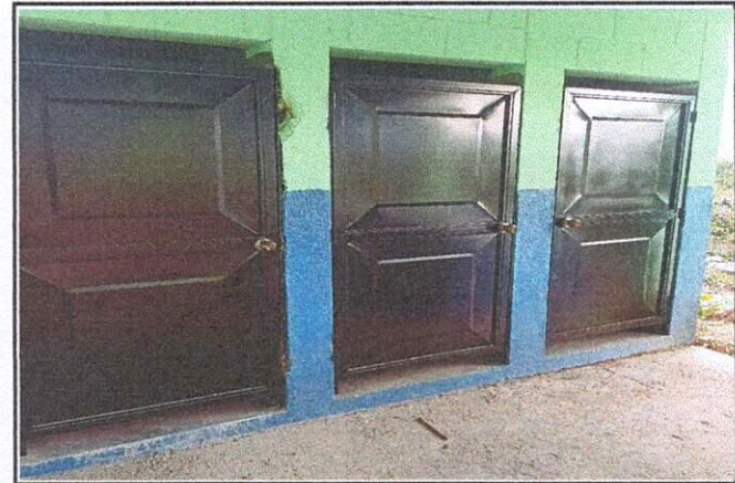
Foto 4: puertas de los baños cambiadas.
