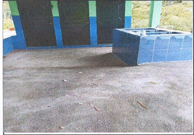
Foto 2: Azulejado de la pila y se mejoro el ingreso a los baños.
