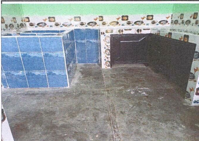
Foto 1: Construcción de tanque pila, azulejada la cocina e instalación de gabinetes de metal.
